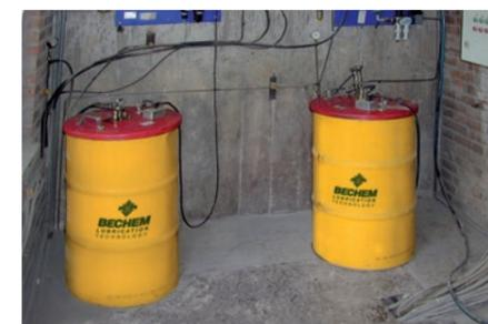
Бочки со смазочным материалом Berulit GA 2500, соединенные с распылительной системой
